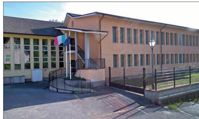
▲ L'Istituto Comprensivo di Sassello
